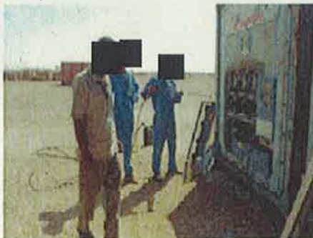
(冷蔵冷凍コンテナの整備)
