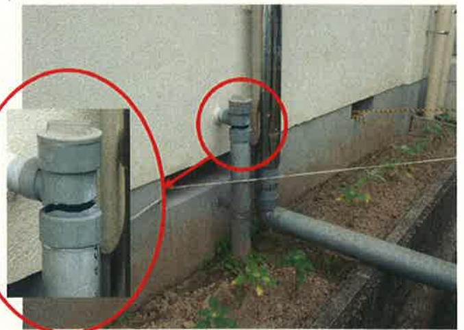
配管破損
